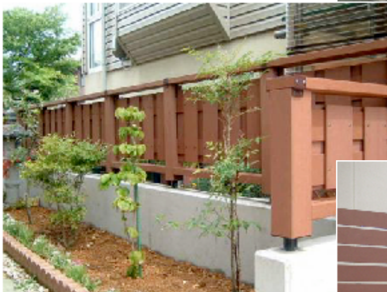
A工事店様施工現場 / 商品種類：M-12K型
