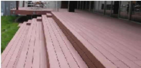
北海道大学テラス階段部
